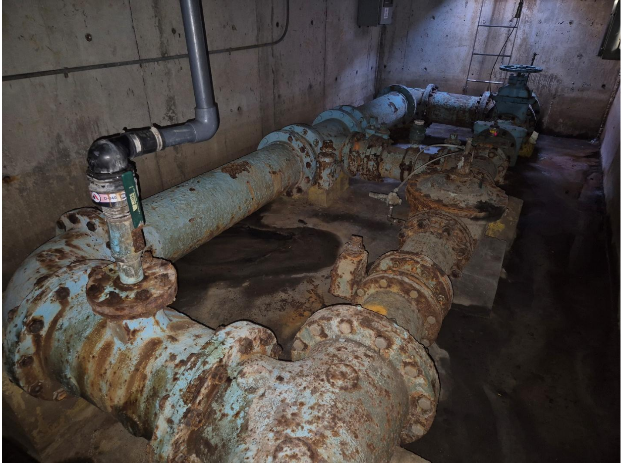
3900 S 900 E Vault
